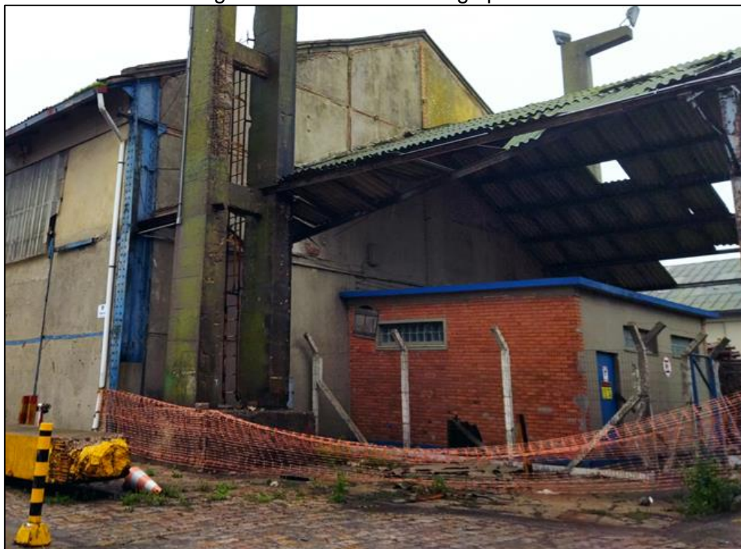
Figura 3 – Fachada Norte galpão A5
