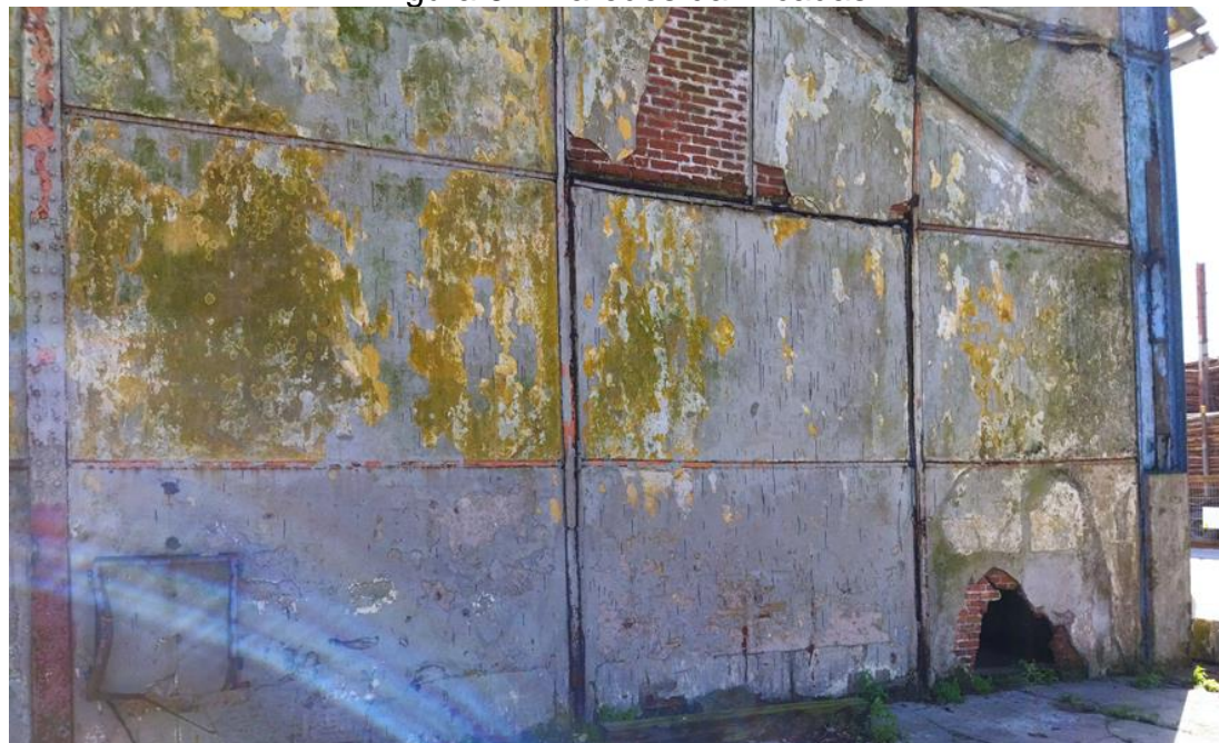
Figura 6 – Paredes danificadas
