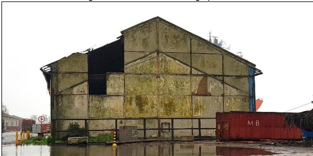
Figura 2 – Fachada Sul do galpão A5
