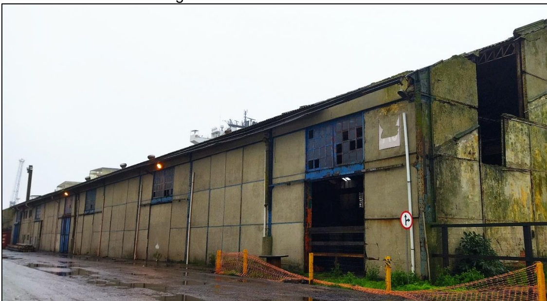
Figura 5 – Fachada lateral Oeste
