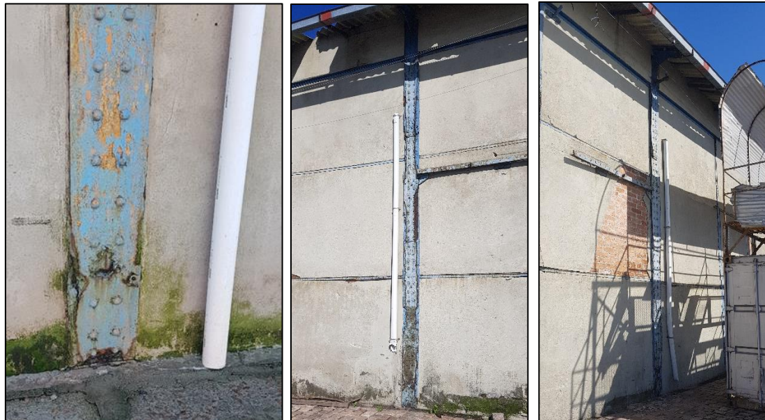
Figura 5 – Pilares e condutores pluviais
