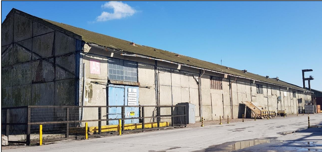
Figura 4 – Fachada lateral Leste
