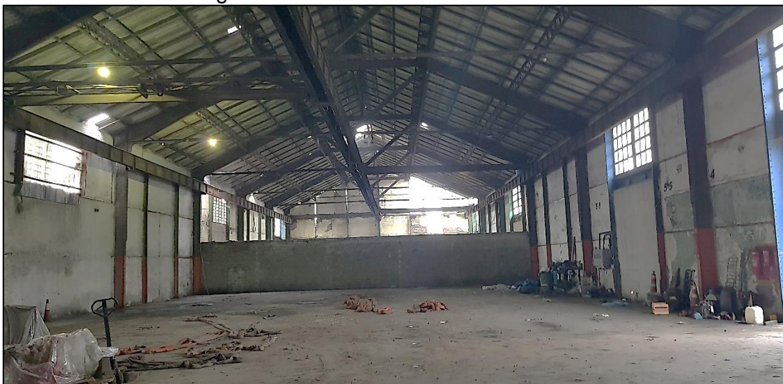
Figura 9 – Vista interna do Armazém A5
